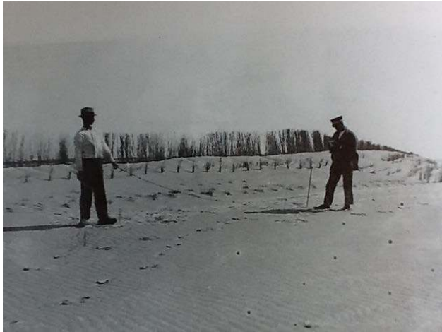
FIGUUR 63 Opmetingen voor de aanleg van een stuifdijk bij de Noordvaarder. Links Symen Kroon (naamgever van de Kroonpolder). SML 2000.
